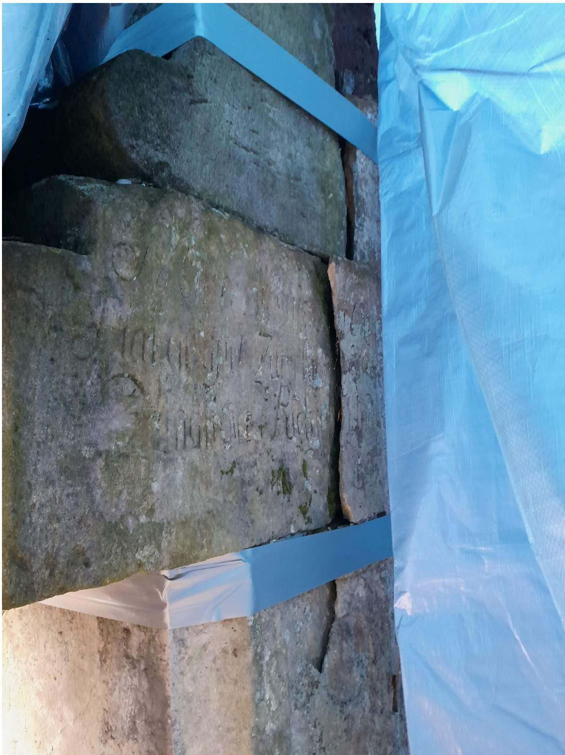
Překrytí soklové části krycí plachtou.
