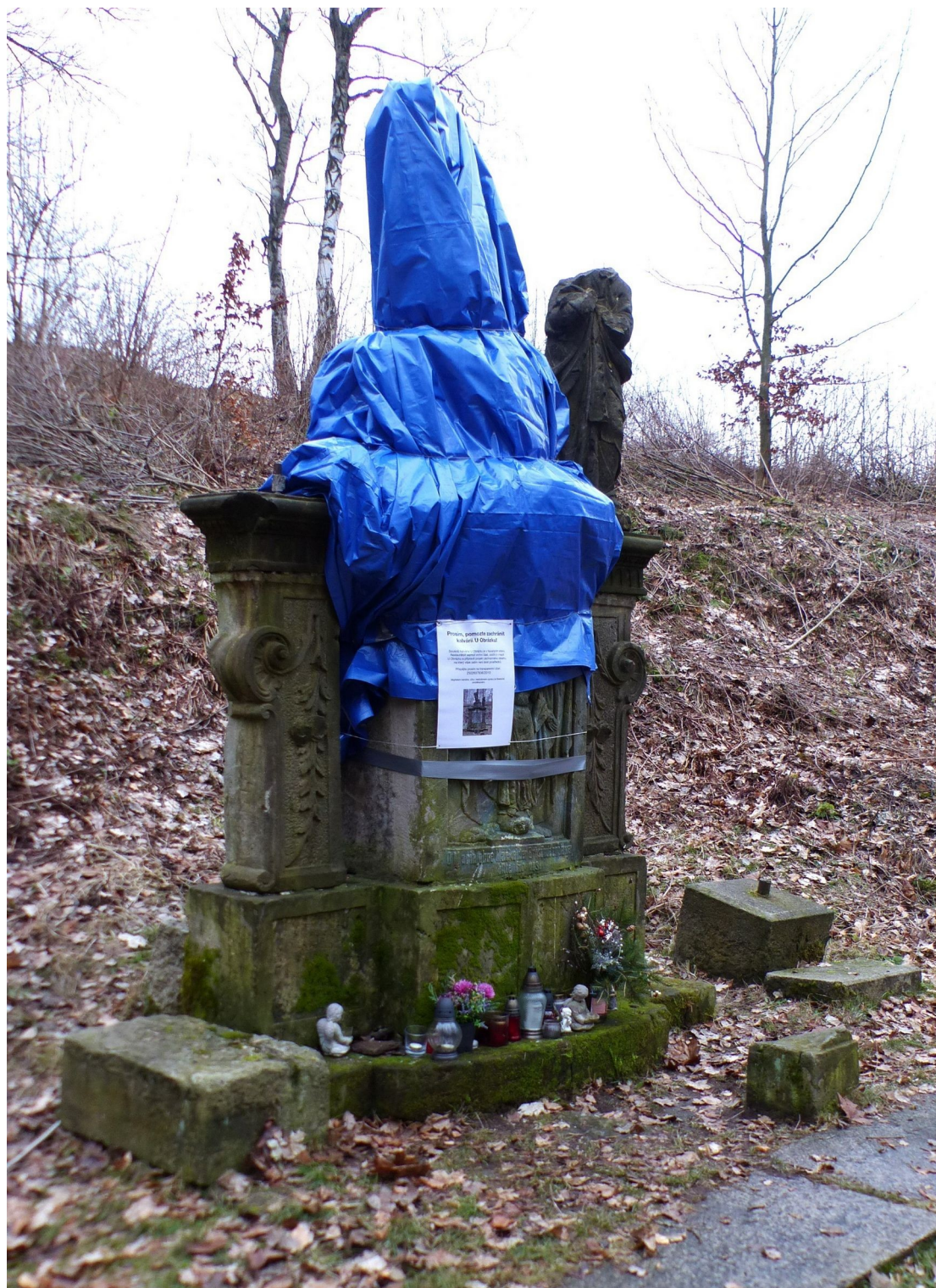
Překrytí soklové části krycí plachtou.
